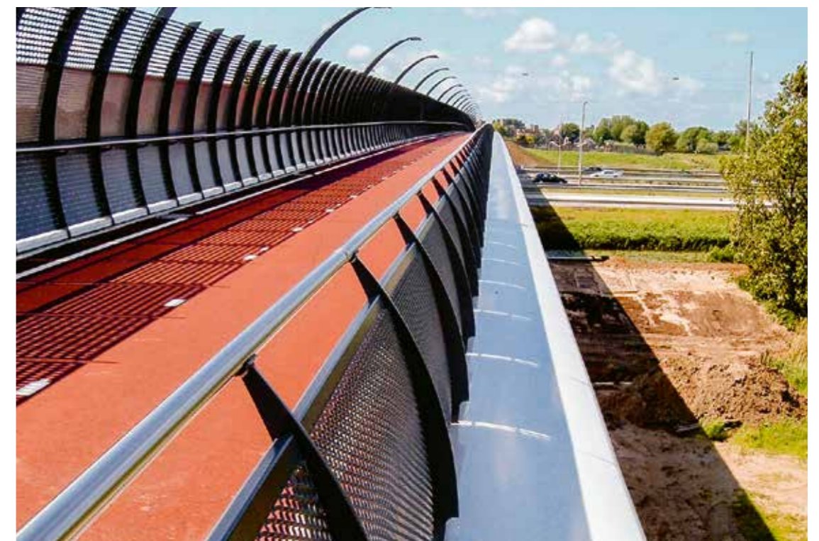
Brücke Leidschenveen, Den Haag
